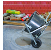
Aanbrengen gietvloer m.b.v. karretje
