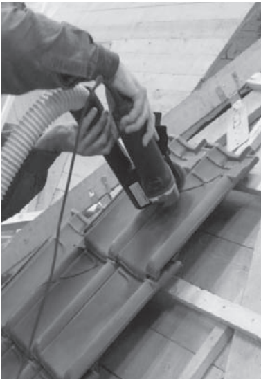
Foto 1 Haakse slijper met afzuiging
