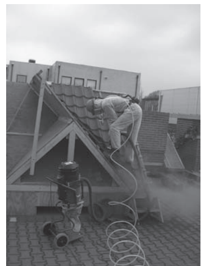
Foto 6 Zagen dakpannen in een proefopstelling
