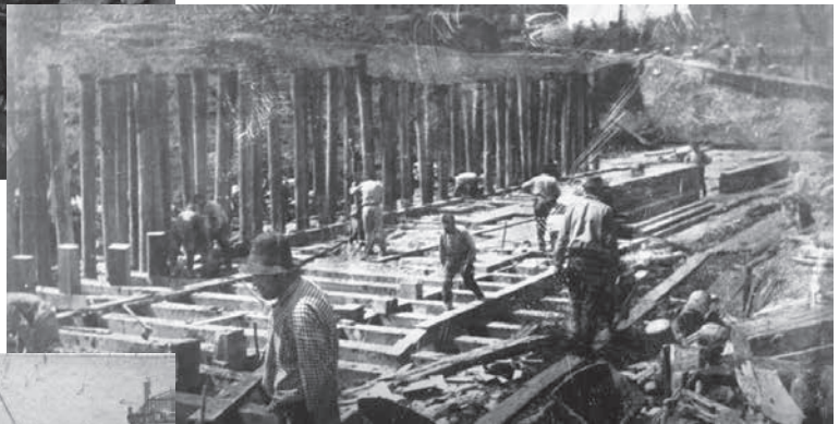
Heiwerk in de Raadhuisstraat in Amsterdam (ca. 1898)
